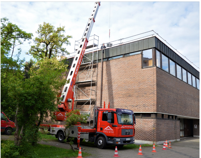
Die Lätare-Kirche anlässlich der Dachsanierung im Jahr 2018
